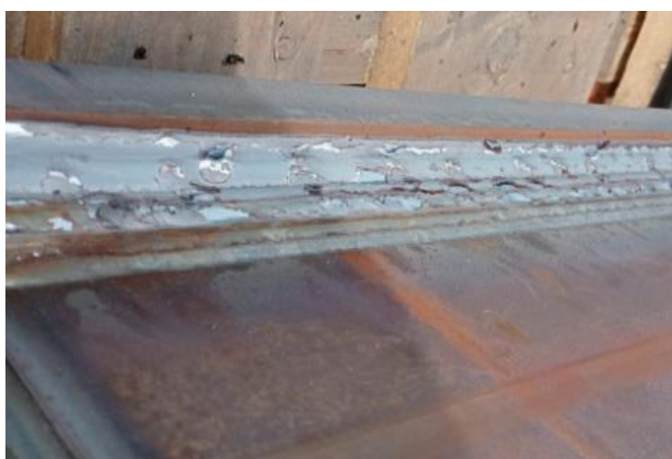
Figura 7 – Saldatura ad angolo multi-pass presso MTS
