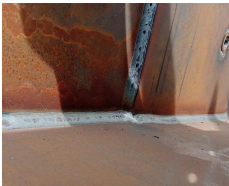
Figura 6 – Saldatura ad angolo in passata singola presso MTS
